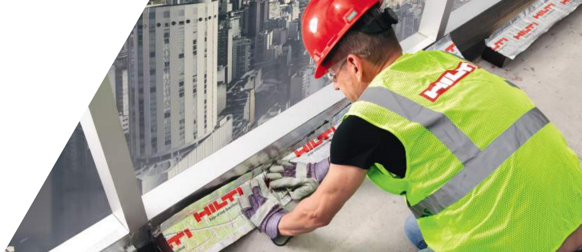
Para a construção de pele de vidro, um dos seus maiores desafios é vedar a lacuna entre as lajes do piso e a fachada. Este pequeno vazio é na realidade a maior junta em um edifício e pode agregar centenas de metros quadrados de espaço aberto, potencialmente permitindo que gás, fumaça e chamas subam de um andar a outro. Não é surpreendente que quase todos os códigos de construção internacionais reconheçam a importância crucial das barreiras de perímetro para a segurança geral dos edifícios.
